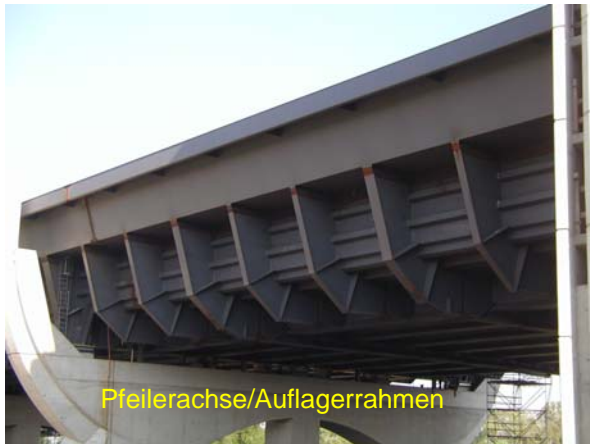
Bild 2 Tragstruktur eines Feldes
