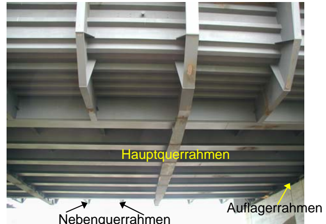
Bild 3 Rahmen in Querrichtung
