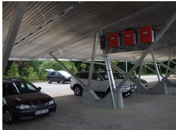
**Bild 14** Wechselrichterbefestigung
