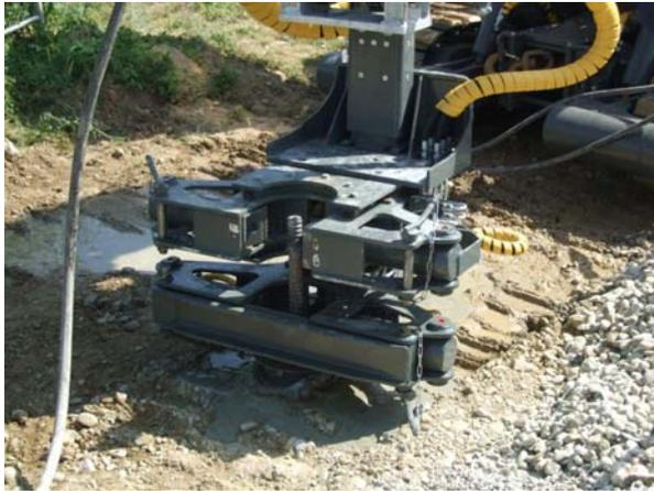
**Bild 11** Einbau von Micropfählen
