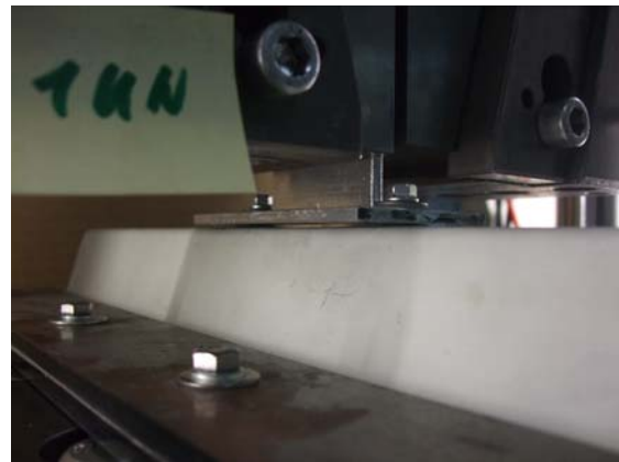
Bild 4 Deformation bei einem Hochsickenanschluss
