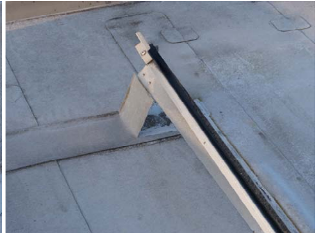
Bild 9 Versagen durch Reißen der Klebelasche
