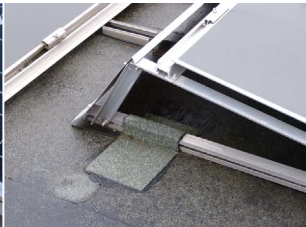
Bild 2 Fixierung mit geschweißten Laschen auf Bitumen
