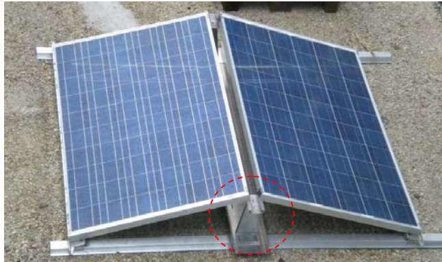
Bild 20 ballastarmes System Ost-West-Aufständerung
