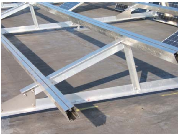
Bild 3 Aufständerdreieck mit Winkeln
